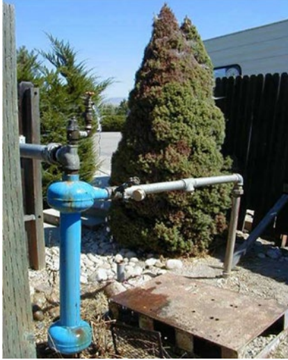
Figura 1: La boca de pozo en su propiedad típicamente incluye un tubo que va a su tanque de presión.
