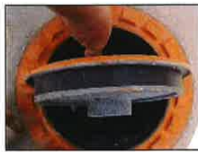
Spill bucket lid gasket
